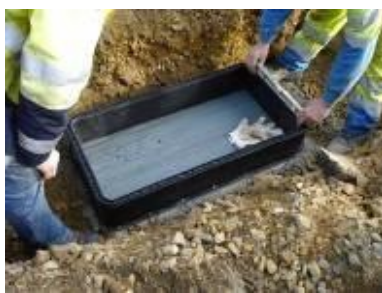
1 - Dégagement conduite 2 - Fond sur béton d'assise 3 - Percement
