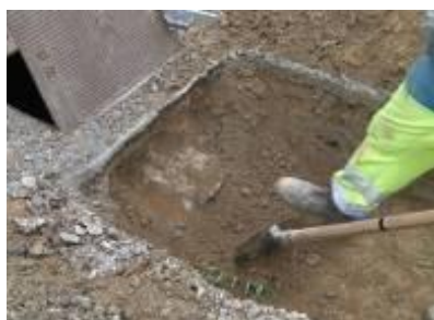
1 - Dégagement conduite 2 - Fond sur béton d'assise 3 - Percement
